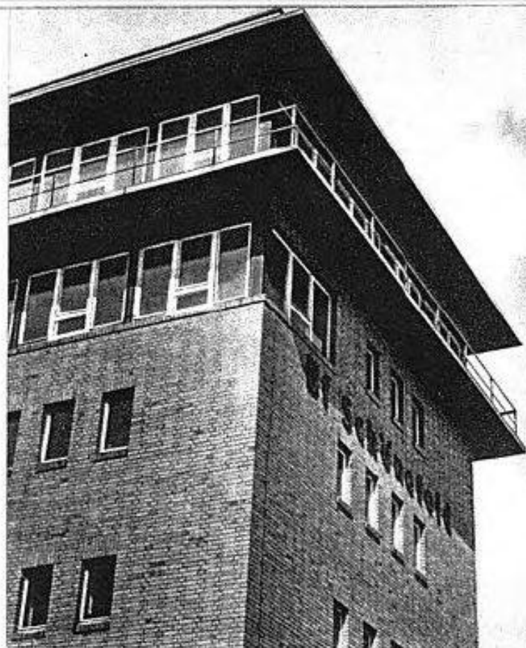
Im Juli 1951 war das größte Bauwerk der Deutschen Reichsbahn, der südliche Berliner Außenring, fertiggestellt. Beherrschend blickt das moderne Gleisbildstellwerk Bf Schönfeld auf die gewaltigen Anlagen.
