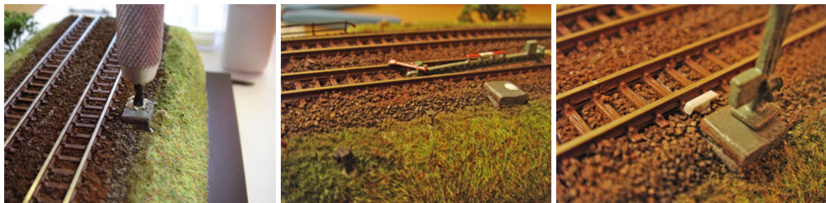
Zuerst wird mit dem Handbohrer ein Loch von 2,5 mm Durchmesser für den Signalsockel vorgebohrt, anschließend mit Weißleim verfüllt und schließlich der Signalmast eingesetzt. Eine kleinere Bohrung im Schotterbett zwischen zwei Schwellen nimmt den im Text beschriebenen Indusi-Gleismagneten großer Bauform auf.
