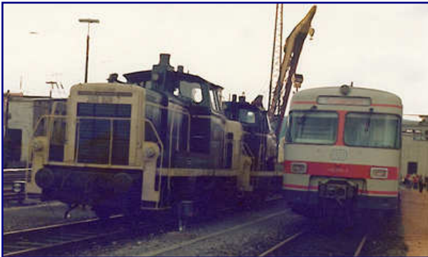
Der Triebzug der Baureihe 420 (rechts), der Allachsantrieb besitzt, hatte seine Feuertaufe während der Olympischen Spiele in München. Auf einer Fahrzeugausstellung ist er 1979 in Hagen im Farbkonzept für die S-Bahn Rhein-Ruhr zu sehen. Mit der Baureihe 260 (links) wagte die Bundesbahn 1978 in Dortmund erstmals den Versuch einer Fernsteuerung von Loks. Foto: H.-D. Späing
