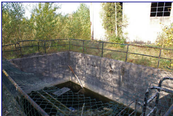
Eine verbliebene Spur der eigenen Wasserversorgung ist der Grobfang zwischen dem ehemaligen Freistand 20 und 21.
