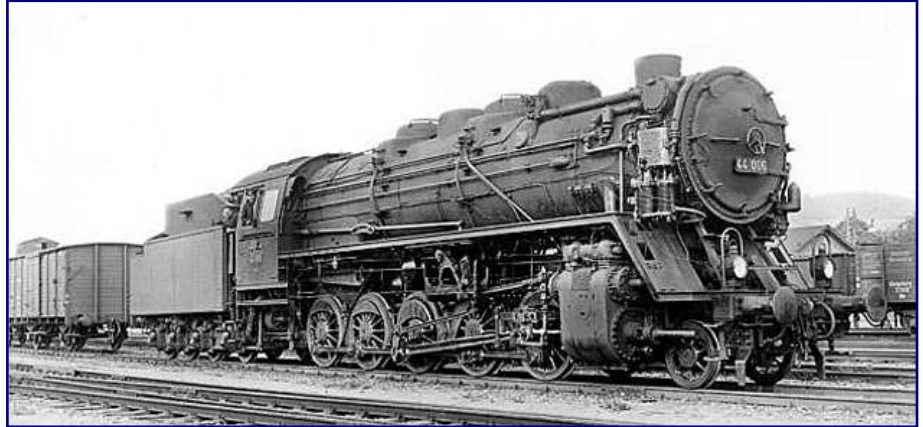
44 006 gehörte zu den ersten 10 Lokomotiven, die 1926 zu Vergleichszwecken gebaut wurden. Diese Maschinen trugen noch keine Windleitbleche, wohl aber eine Frontschürze. Zu sehen ist die Lok 1930 im Bahnhof Pressig-Rothenkirchen an der Frankwaldbahn. Foto: Carl Bellingrodt, Sammlung Eisenbahnstiftung
