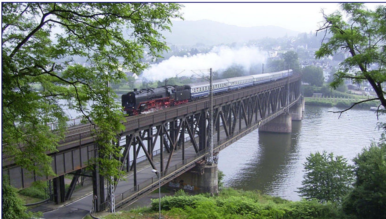
01 118 der Historischen Eisenbahn Frankfurt überquert am 10. Juni 2007 mit einem Sonderzug auf der Doppelstockbrücke von Bullay die Mosel. Wie sie blieben viele Null-Einser erhalten, darunter auch mehrere betriebsfähige Exemplare. Foto: Jörg Neidhöfer
