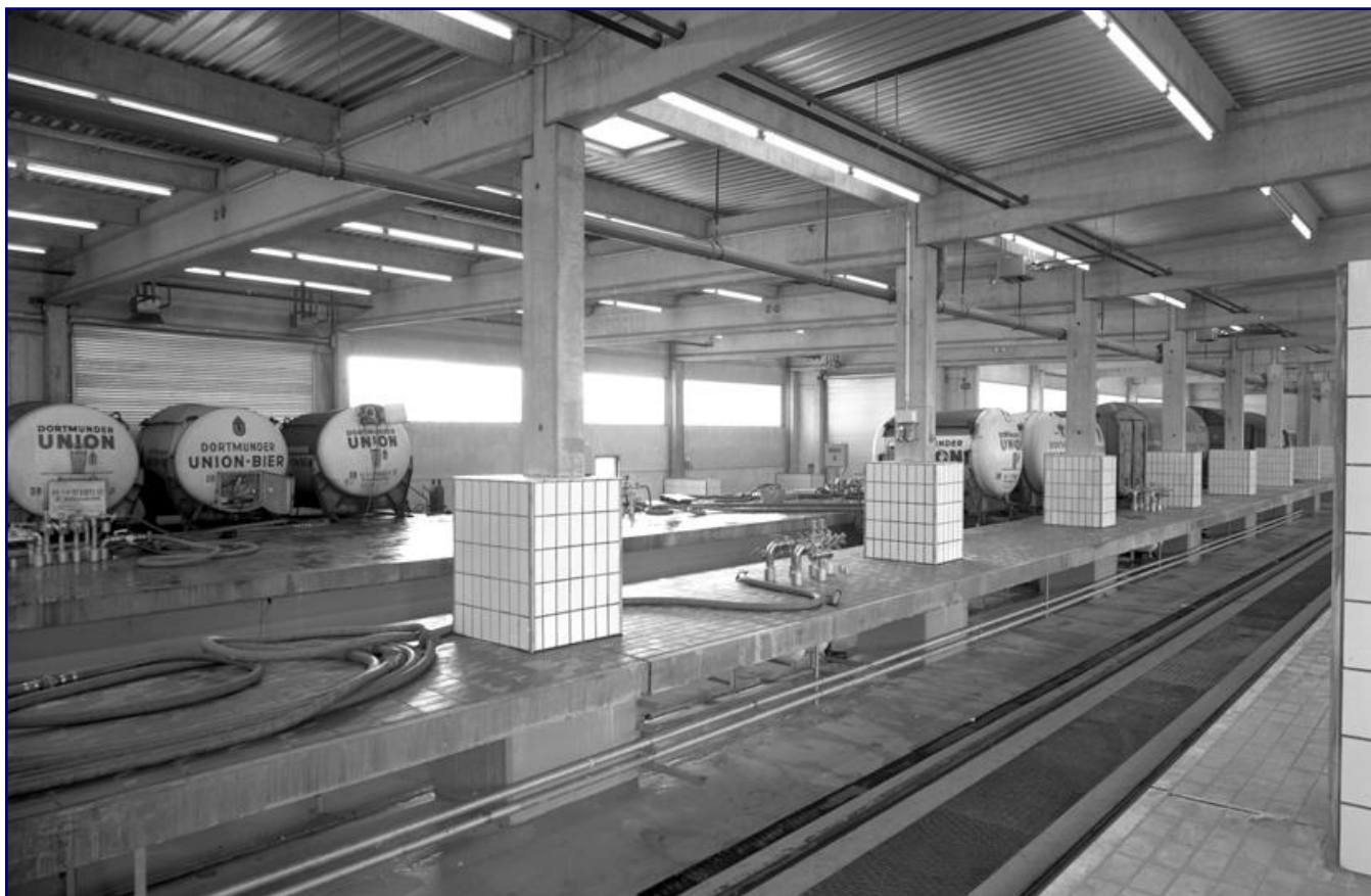
Blick in den fertig gestellten Containerbahnhof der DUB im Jahre 1973: Hier werden vor allem die Mittelcontainer der Behältertragwagen befüllt (siehe Wagen links im unteren Bild), aber auch gedeckte Wagen mit Bierfässern und -kästen beladen. Beide Fotos: Foto-Studio Harald Koechlin, Archivnummern 1514-2 (oben) & 1514-1 (unten)
