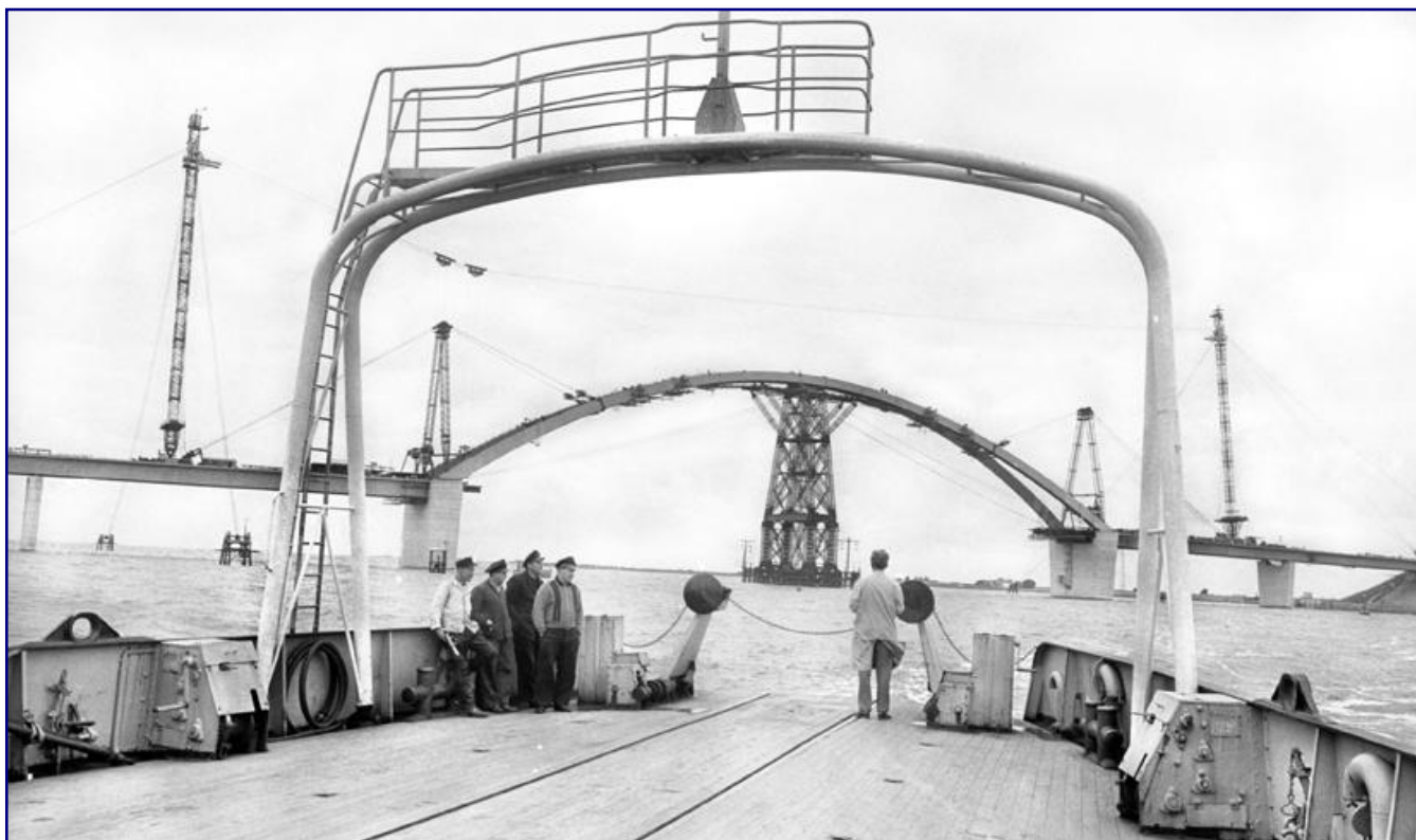
Vom Fährschiff „Schleswig Holstein“ richtet sich am 14. September 1962 der Blick auf die Baustelle der Fehmarnsundbrücke. Der Bogen mit einer Spannweite von 248,50 m ist am 5. September geschlossen worden, die Fahrbahn fehlt noch – einige Inselbewohner fragen sich bei diesem Anblick, wie man den wohl überfahren soll. Im Bild festgehalten wurden auch das mittige Hilfsgerüst und der Kabelkran. Foto: Walter Hollnagel, Sammlung Eisenbahnstiftung
