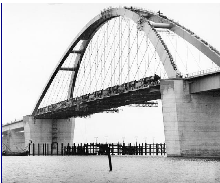
Am 22. April 1963 erfolgte eine Belastungsprobe des Haupttragwerks mit dem Gewicht von zehn Dampflokomotiven (1.600 Tonnen). Foto: Walter Hollnagel, Sammlung Eisenbahnstiftung
