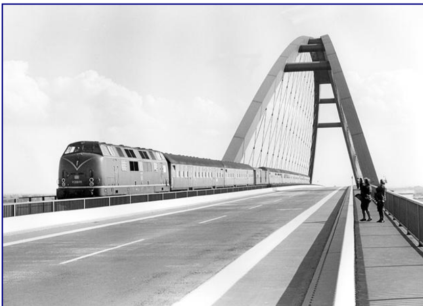
Bild oben: Die kombinierte Eisenbahn-Straßen-Brücke wurde schnell zum Wahrzeichen der Vogelfluglinie und von Schleswig-Holstein. Am 28. September 1963 überquert V 200 111 das 963 m lange Bauwerk. Foto: Walter Hollnagel, Sammlung Eisenbahnstiftung
