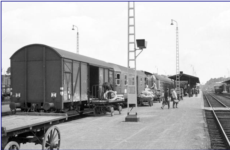
Dieser Gms 54 läuft im August 1962 am Ende eines Wendezugs mit. Beim Halt in Marktredwitz wird er beladen. Der Zug besteht aus einer V 100 und Silberlingen – beides gehört zum Modernsten, was die Bundesbahn zu bieten hat. Foto: Walter Patzke, Sammlung Petkelis
