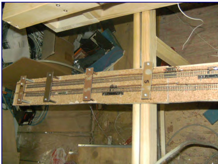
Eine Tunneloberleitung muss technischen Ansprüchen genügen – nicht optischen. Foto: Günter Mai
