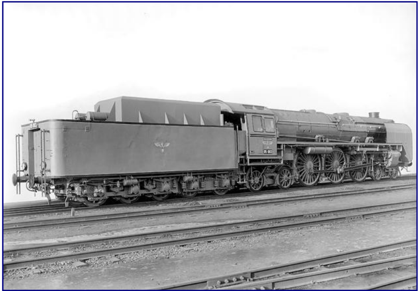
Der Umbau von 05 003 auf eine Dampflok der Regelausführung gestaltete sich kompliziert und zog sich wegen des Kriegs lange hin. Erst im Februar 1945 konnte sie an die Reichsbahn zurückgegeben werden. Zu sehen ist sie hier im Werk der BLW in Hennigsdorf bei Berlin. Foto: Slg. Tiemann (Eisenbahnstiftung)
