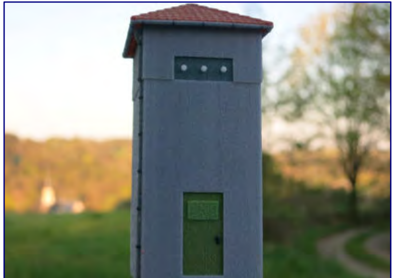
In natürlicher Umgebung spielt das neue Trafohaus von Schrax seine Reize voll aus. Foto: Schrax
