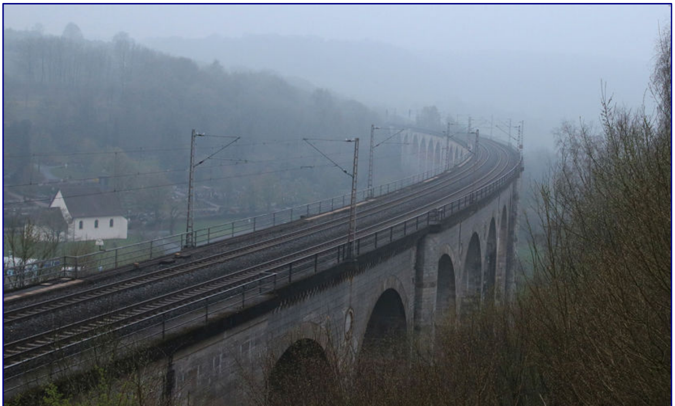
Noch ziehen zur frühen Morgenstunde Nebelschwaden über das Altenbekener Viadukt, doch schon bald sollte es ganz in der Nähe los gehen und mit der Ruhe vorbei sein.
