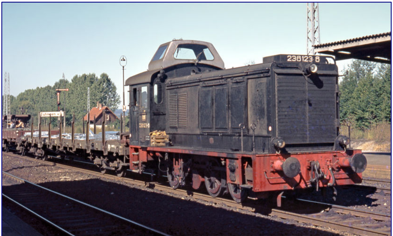
236 123-6, die Vorlage zu Märklins jüngstem V-36-Modell, hilft am 4. September 1973 bei den Elektrifizierungsarbeiten im Bahnhof Eutingen. Foto: Wolfgang Bügel, Eisenbahnstiftung
