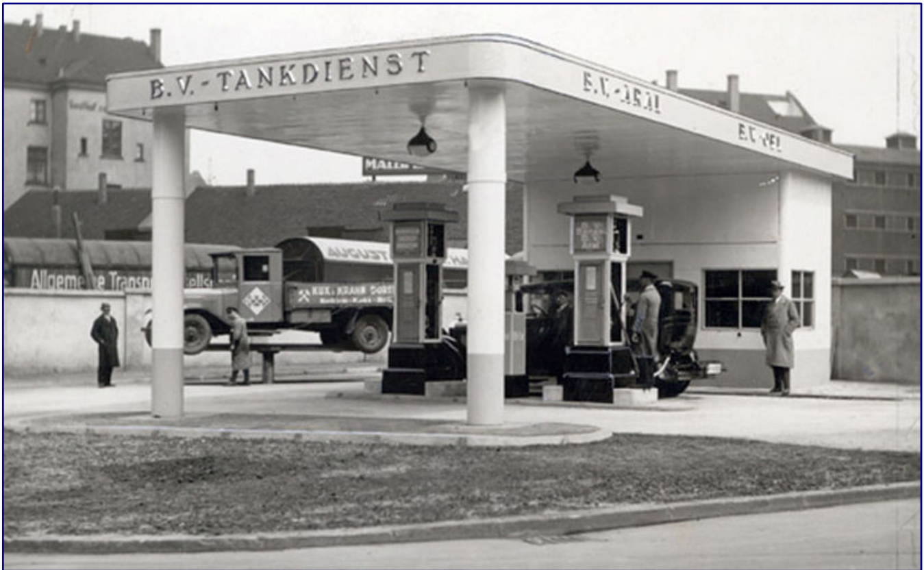
Ein früher Vertreter der Großtankstellen ist diese BV-Aral-Station im Jahre 1939. Typisch sind die hohen Handpumpensäulen und die noch im Freien stehende Hebebühne für Arbeiten am Kraftfahrzeug. Foto: Historisches Archiv BP/Aral
